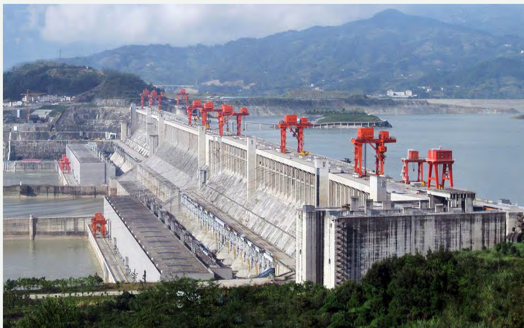
Barrage hydroélectrique des Trois Gorges, province du Hubei, Chine (Wikimedia Commons)
