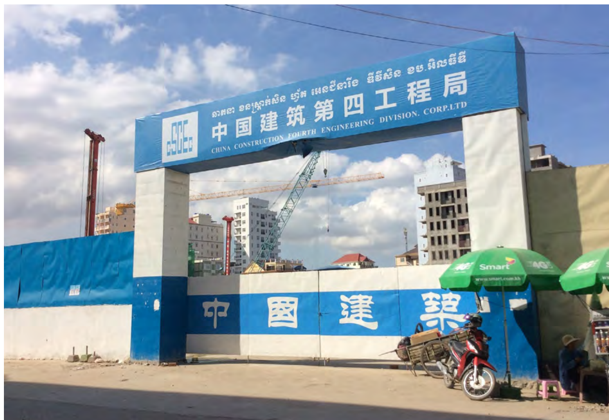
Construction immobilière chinoise contractée par CSCEC, Phnom Penh, Cambodge (par IDI)
