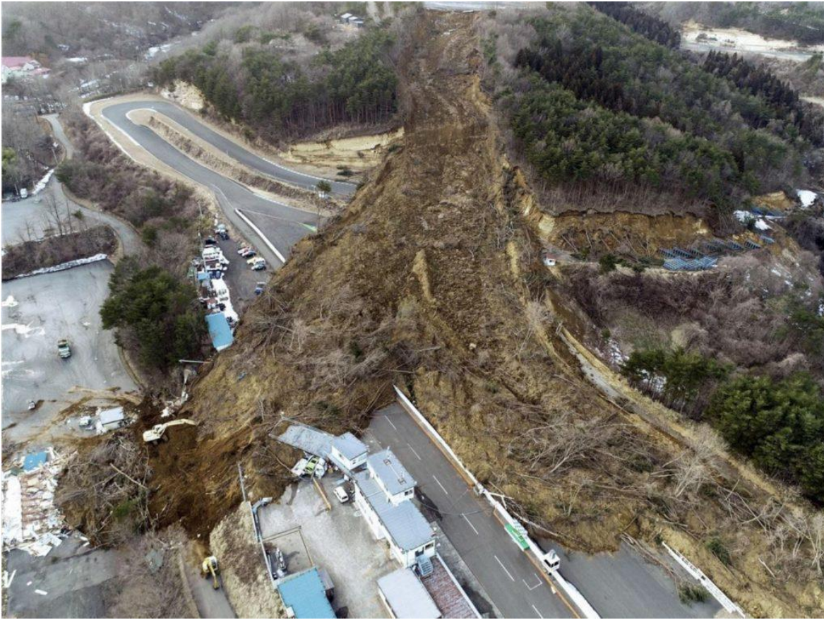
图11 2020年日本：由火山灰覆盖的山体发生滑坡，同时伴有降雨和地震
