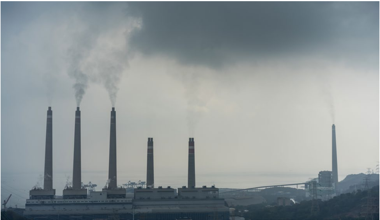
Cerobong asap pembangkit listrik Banten Suralaya menghitamkan langit di dekat Cilegon, Indonesia.
